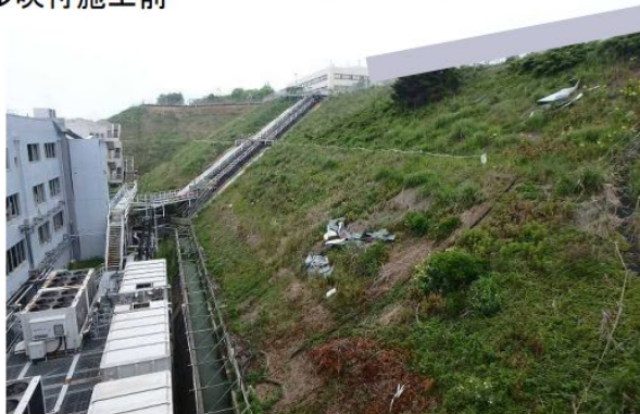
【写真②(35m盤)】北側エリア:旧事務本館法面モルタル吹付施工前
