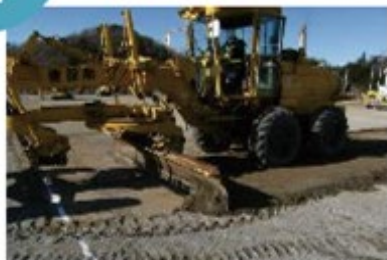
●校庭表土の削り取り
