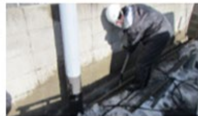
●側溝の汚泥の除去
